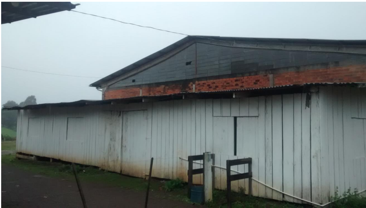
FOTO 1 - Vista frontal do telhado do galpão para animais no parque municipal de eventos
