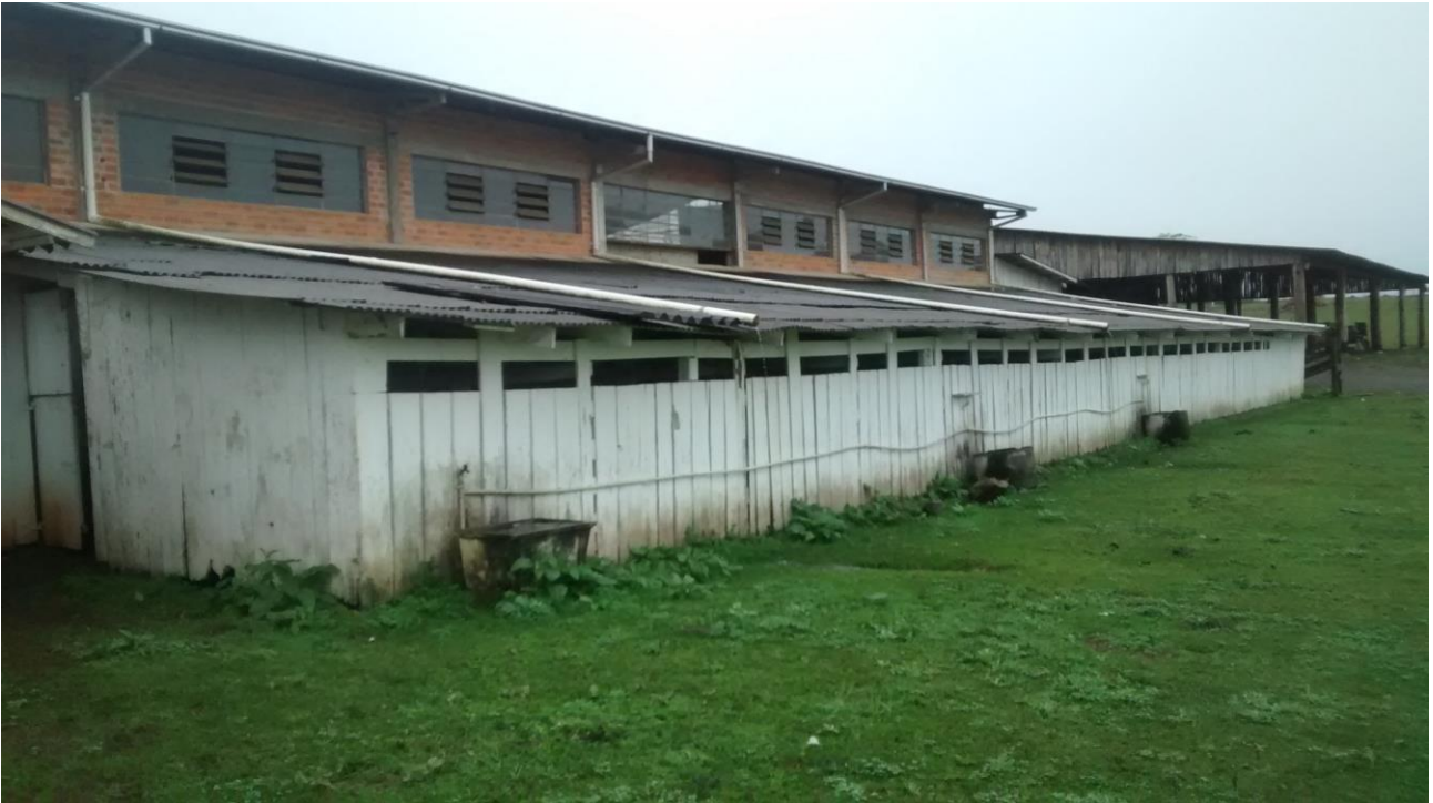
FOTO 1 - Vista frontal do telhado do galpão para animais no parque municipal de eventos
